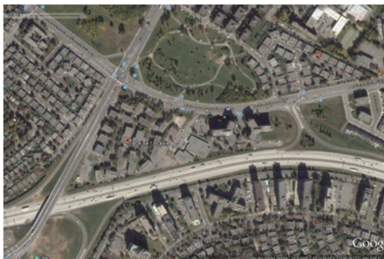
2004 - avant la démolition
