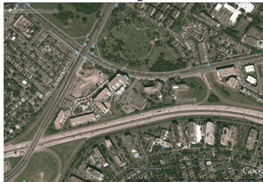
2013 - réaménagement en cours
