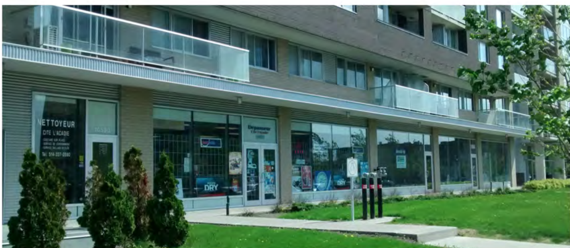
Figures 30 et 31: Présence de commerces au rez-de-chaussée
